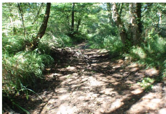
Fig.3 : L'Avance en assec. Pont du Gay 26 Août 2010
